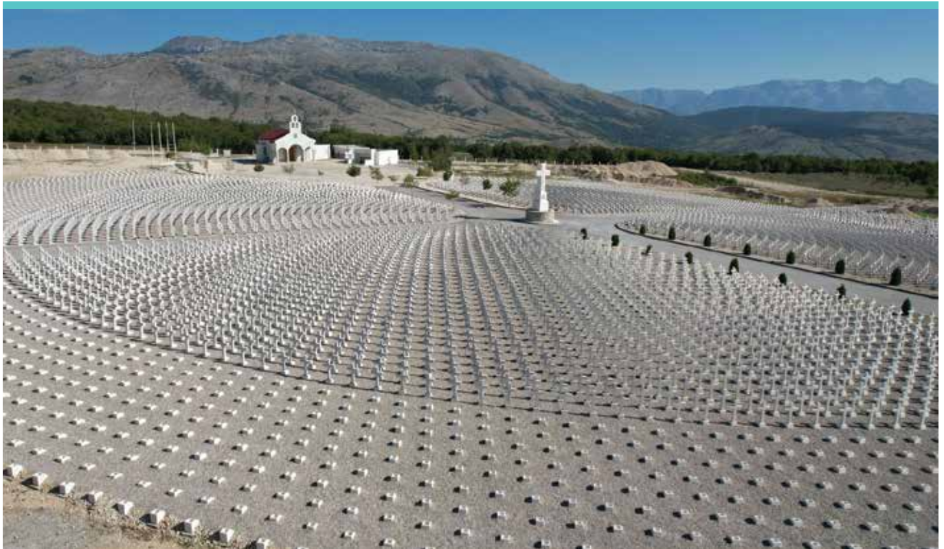
MEMORIJALNI CENTAR GROBLJE MIRA U IZGRADNJI
