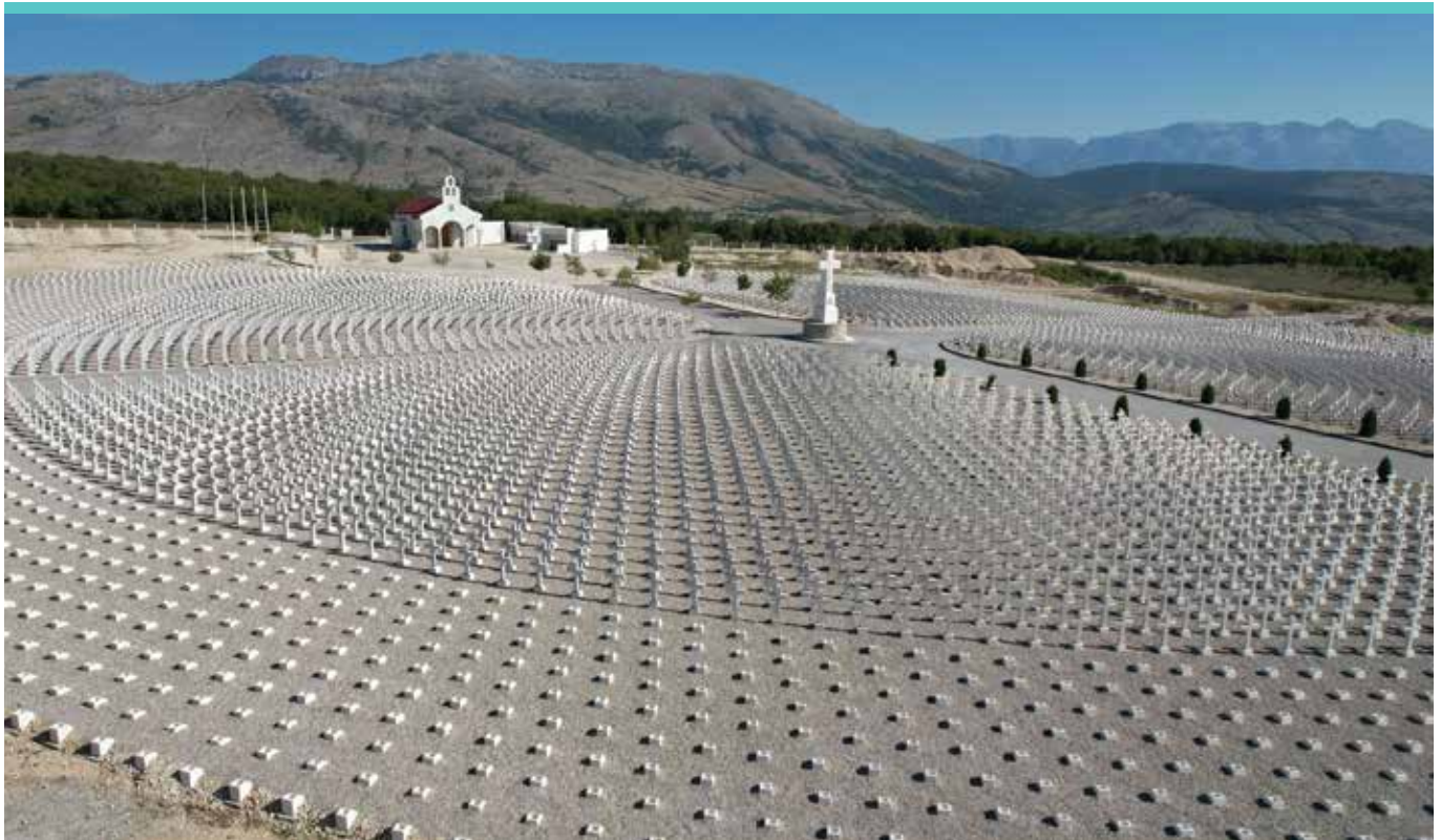
MEMORIJALNI CENTAR GROBLJE MIRA U IZGRADNJI
